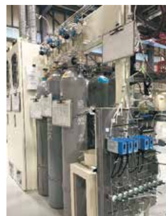
上: 実使用環境測定用 ガス供給系 下: イオンチャンバ用 ガス供給系
