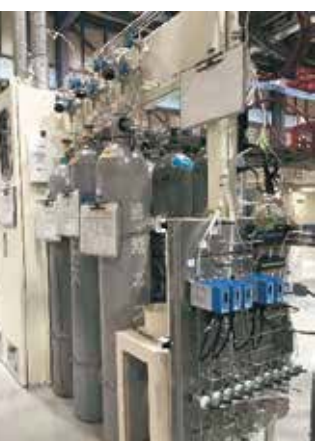
上: 実使用環境測定用 ガス供給系
